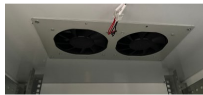
Hình 1.20: Hệ thống làm mát dự phòng
