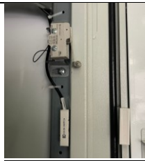
Hình 1.13: Cảm biến mở cửa
