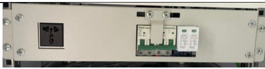
Hình 1.17: Hệ thống AC đầu vào
