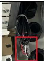
Hình 1.19: cảm biến báo ngập nước
