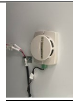
Hình 1.14: cảm biến báo khói
